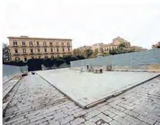
557 GIORNI — PIAZZA CASTELNUOVO Identica data di consegna lavori ma la chiusura di parte della piazza è del maggio 2015. Lo scavo per la futura stazione "Politeama" dell'anello ferroviario non è ancora iniziato
