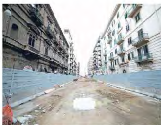
655 GIORNI — VIA EMERICO AMARI La consegna dei lavori all'impresa Tecnis è del 23 luglio 2014. Le trincee per le opere propedeutiche allo scavo con lo spostamento dei sottoservizi compaiono nel gennaio 2015
