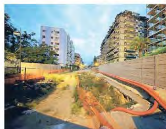
557 GIORNI — VIALE LAZIO Anche i lavori per la fermata di viale Lazio fanno parte di quelli consegnati nel luglio 2014. In questo caso la zona fra viale Lazio e via Sicilia viene chiusa nel maggio del 2015
